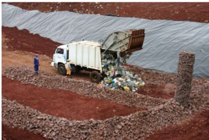
Ilustração 2.1 – Deposição dos RSU em células
