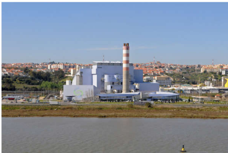
Imagem 06 - Instalação da empresa VALORSUL
